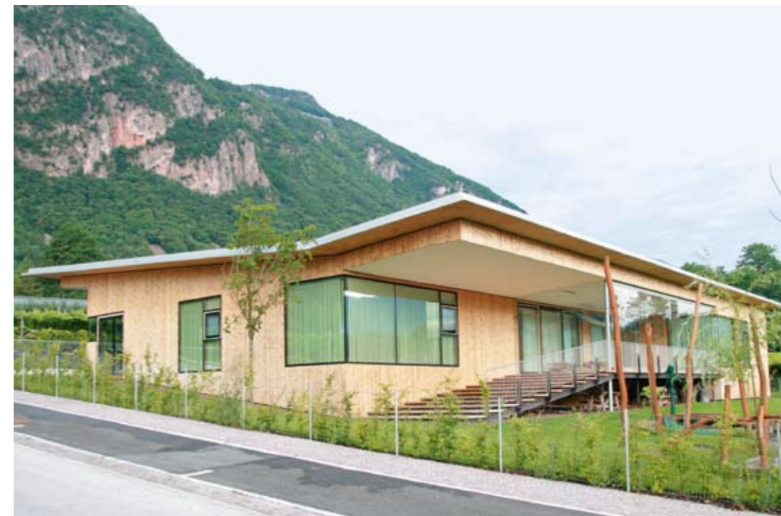
Kindergarten Andrian (BZ) Scuola Materna Andriano (BZ) Arch. Gilbert Dejori; Arch. Michael Dejori
